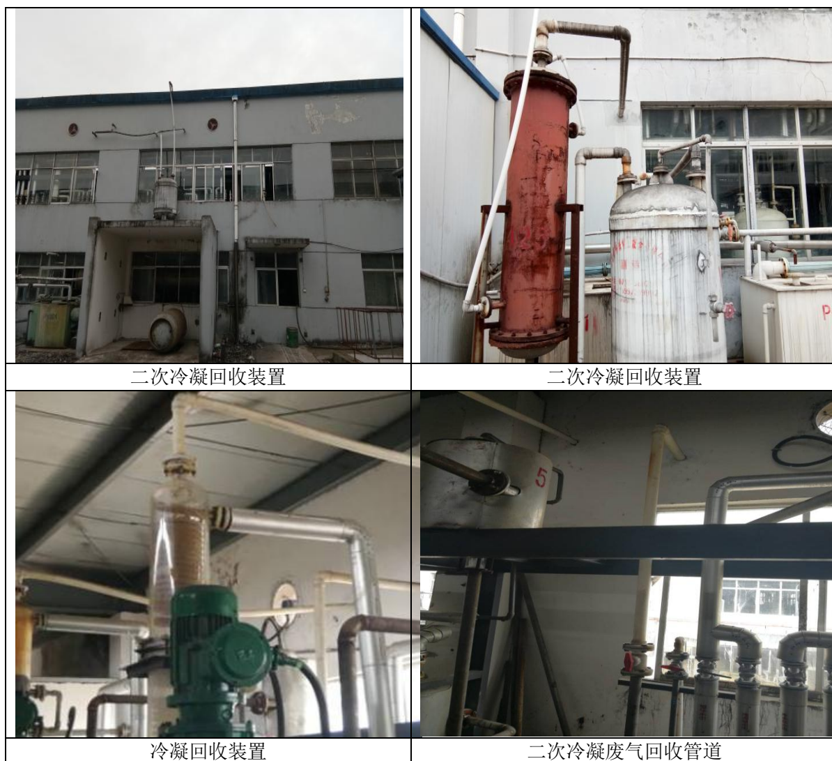
图 4-2 生产车间有机废气处理设施
