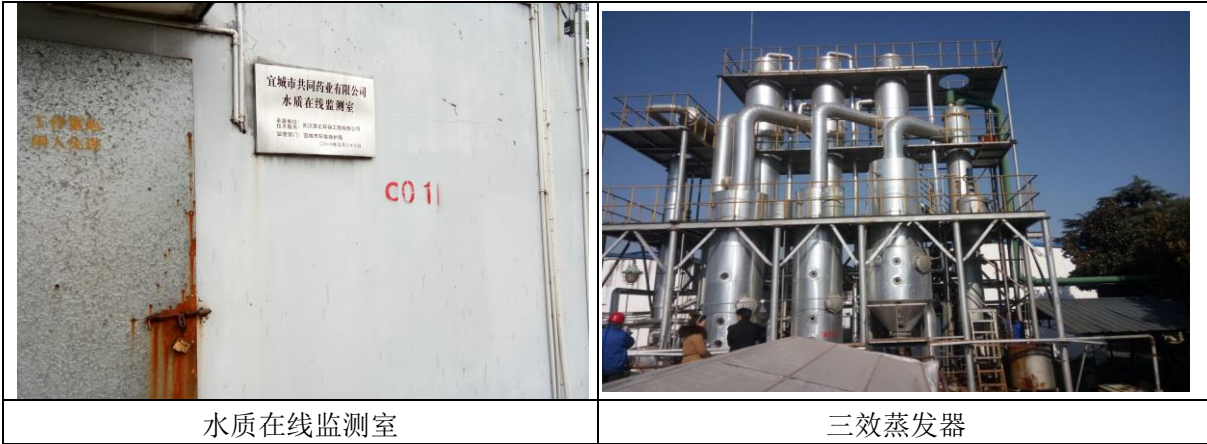
图 4-8 污水处理站实际建设图
