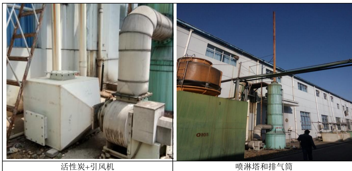
图 4-4 烘干车间废气处理设施
