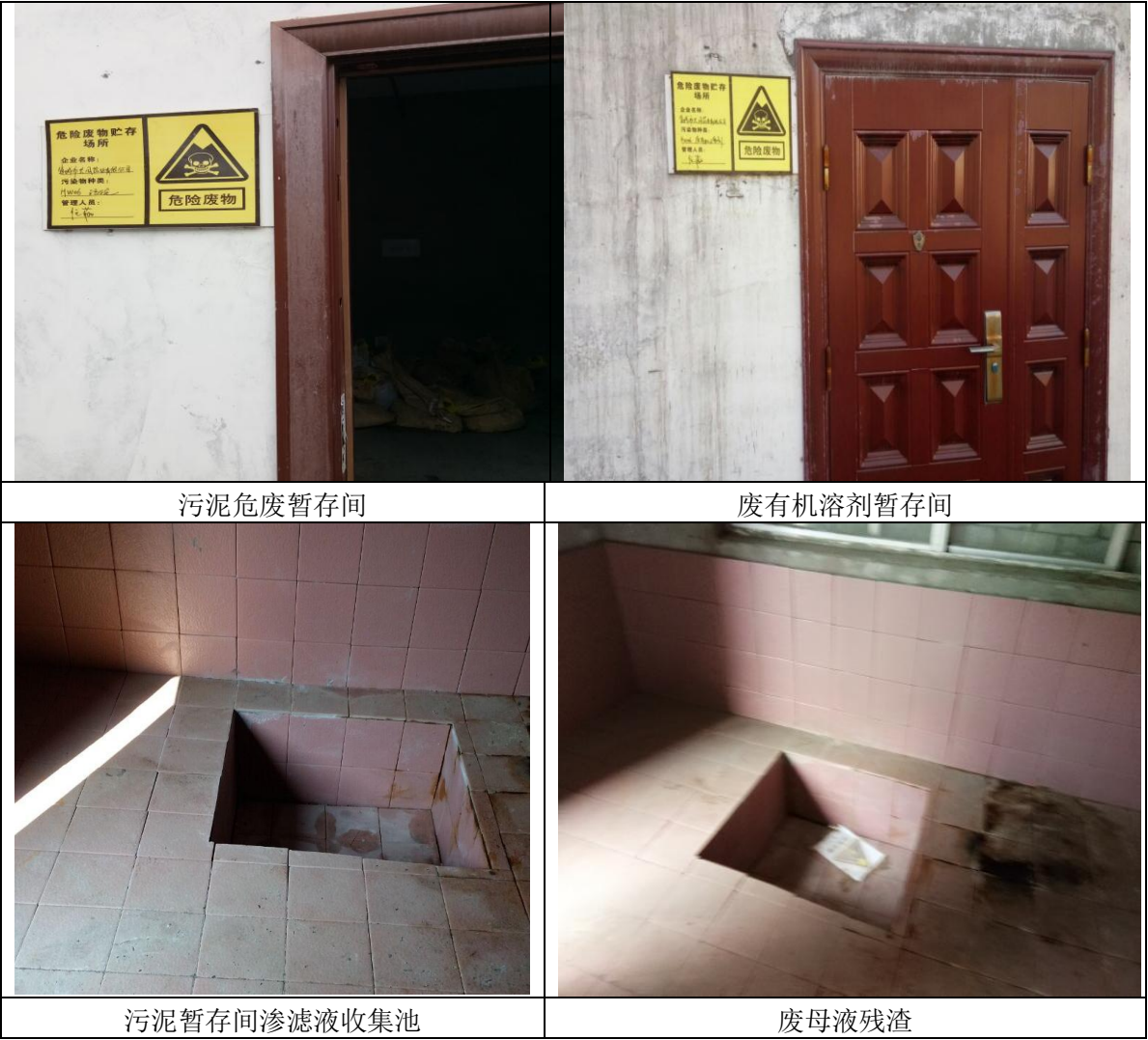
图 4-9 固废处理措施实际建设图
